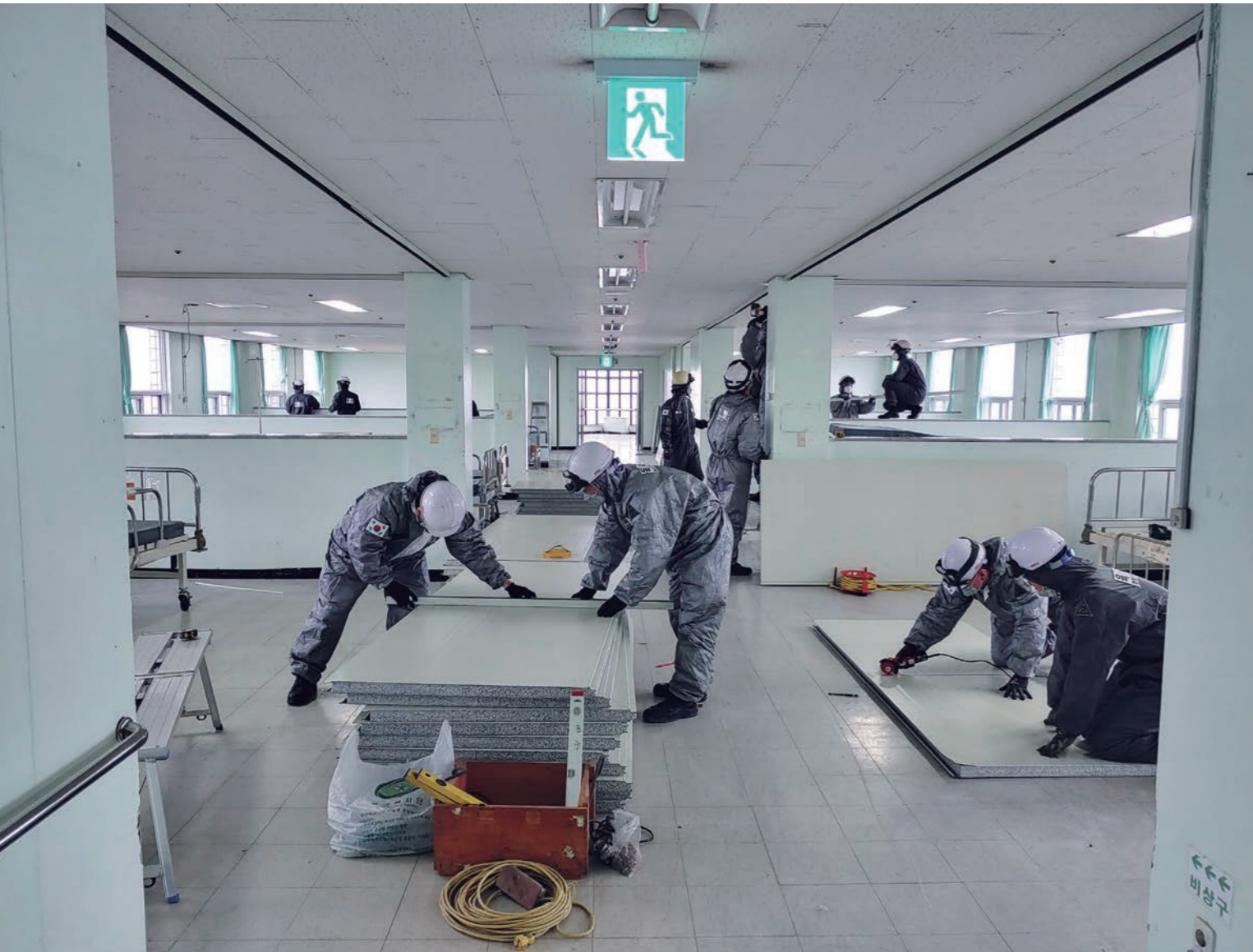
육군2작전사령부 1117공병단은 휴일도 반납한 채 7박8일의 공병작전을 통해 국군대구 병원이 국가 감염병 전담병원으로 신속히 개원되는 여건을 조성한 주역이다. 사진은 1117공병단 장병들이 국군대구병원에서 공사를 진행하던 당시의 모습. ©부대제공
