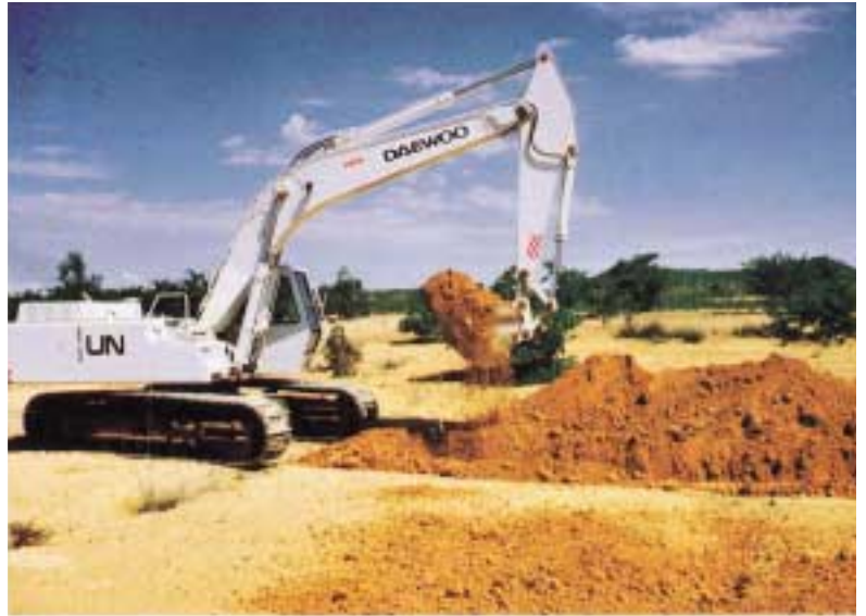
① 우암보공항 배수로 공사
