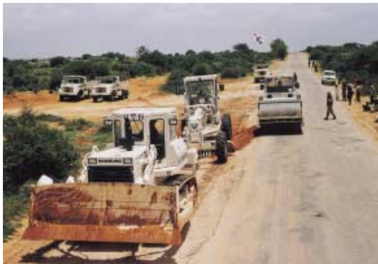
소말리아 발라드와 조하르간의 도로 공사
