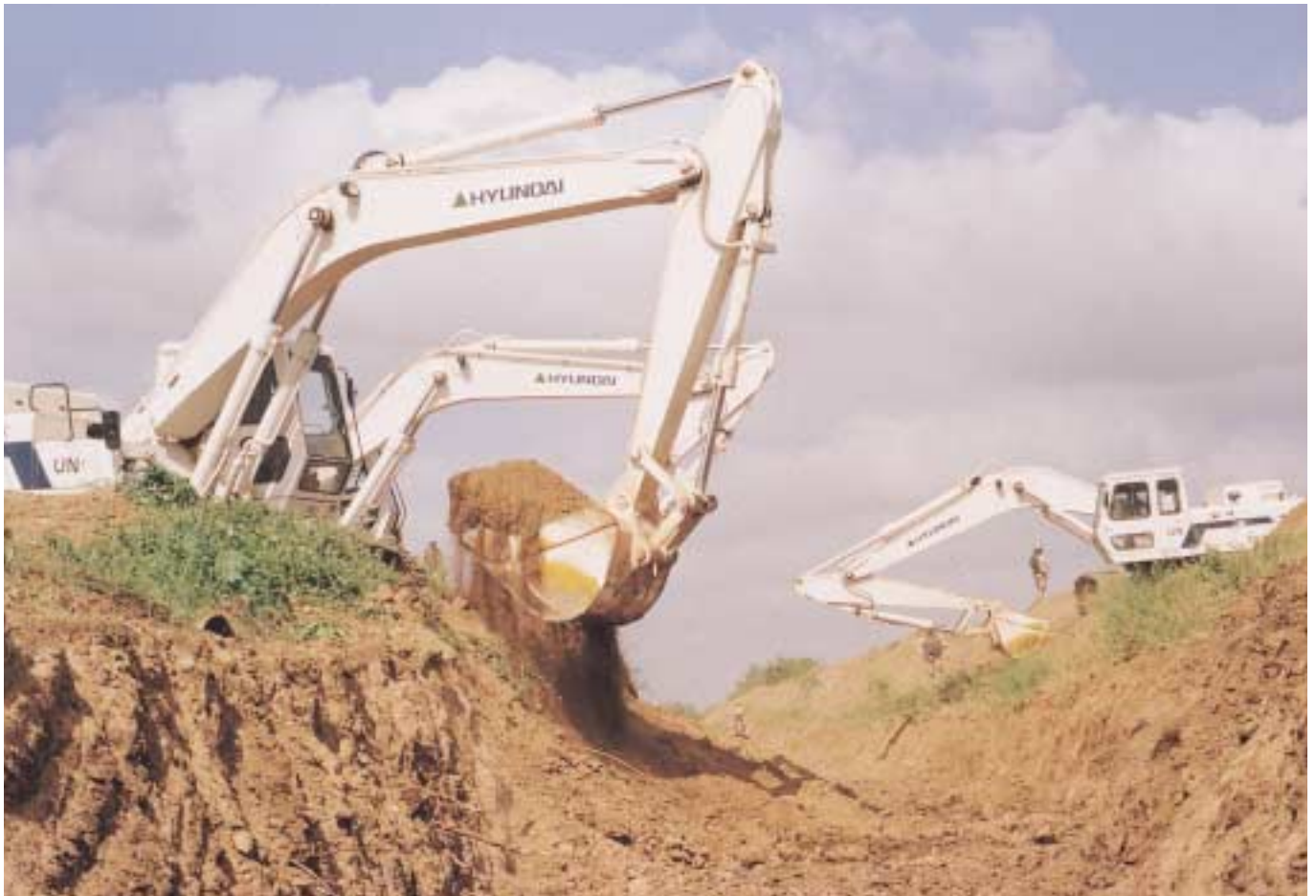
① 하수도 공사
