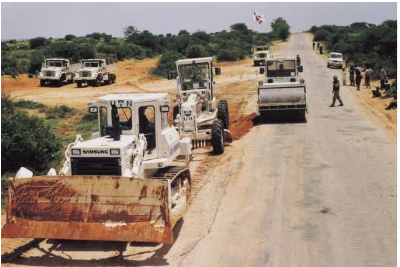
발라드와 조하르간의 도로 공사
