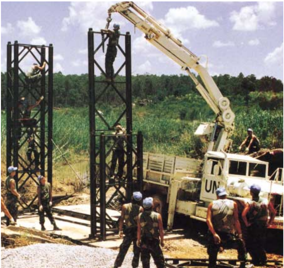
② 꾸이마 교량 복구공사 작업에 땀을 흘리는 장병들
