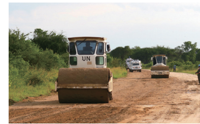
▲ 보르 ~ 망겔라 도로 보수 공사
